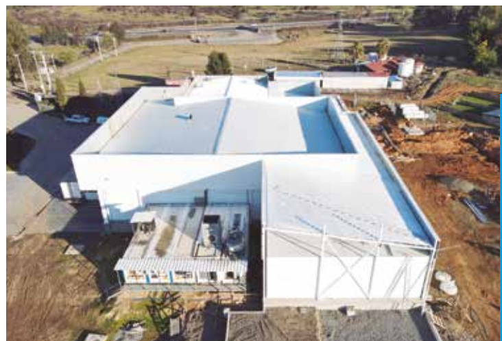
La planta de Tak S.A. sigue creciendo. Concluyó una primera etapa de su ampliación, que consiste en un área destinada a la preparación de carga de productos que permitirá aumentar los volúmenes de despacho.
