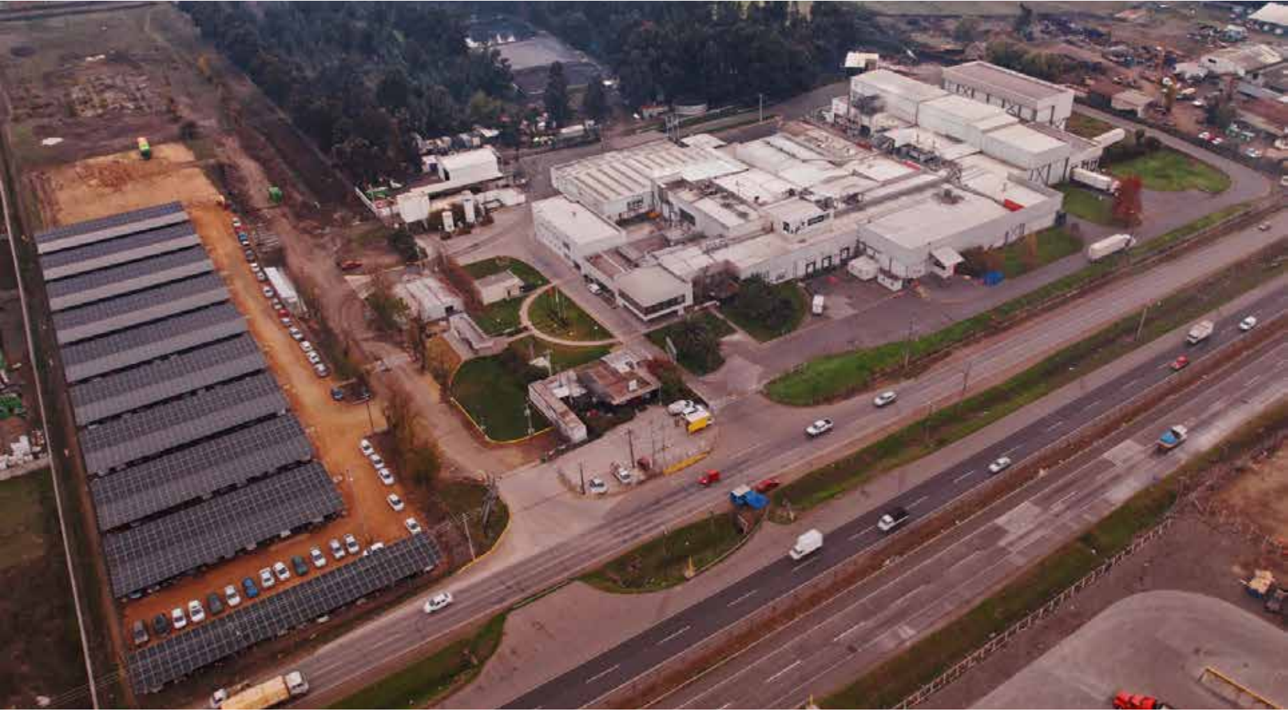
El carport solar de la principal planta de procesos de Coexca S.A. es el más grande ubicado en una región de Chile.
